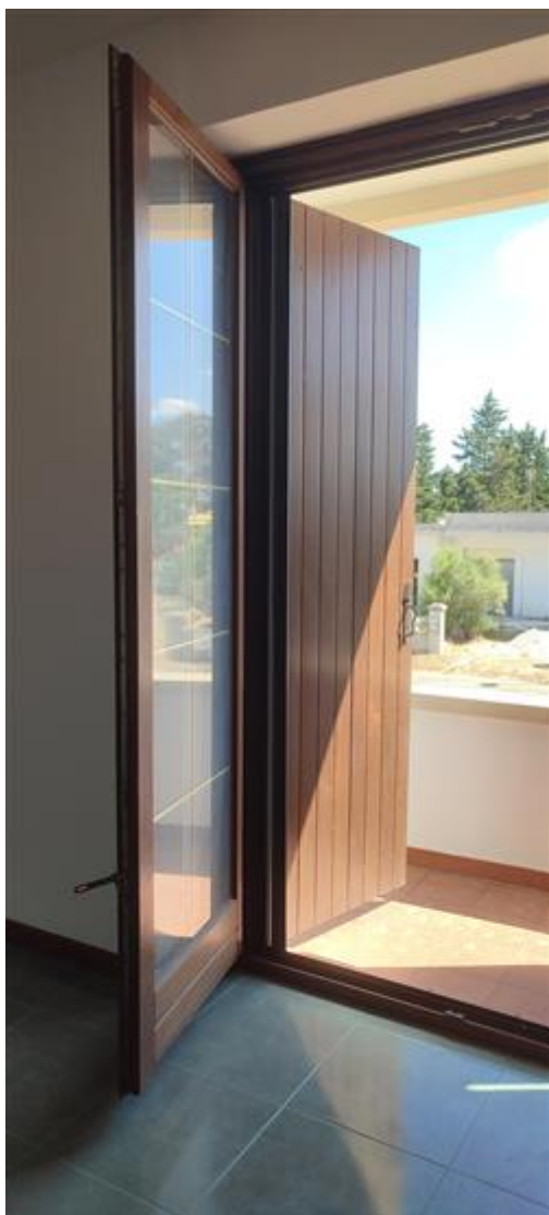
particolare degli infissi esterni, protetti da scuri in legno
