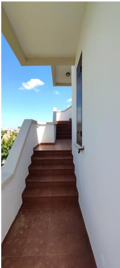
scala per i lastrici soilari a retroprospetto
