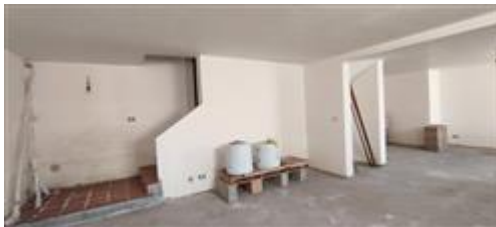
accesso alla cantina dal garage
